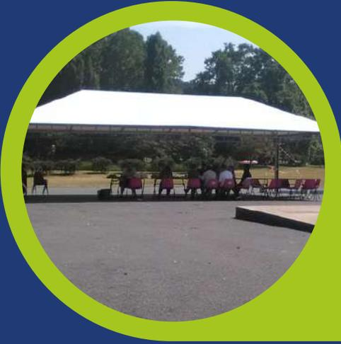
Struttura modulare con strutture portante in ferro per la realizzazione di coperture multiple aventi moduli base di dimensioni 8x8 m, con copertura in telo PVC ignifugo.
